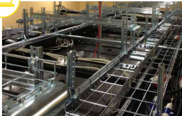
X-Tray le permite encaminar cables a diferentes niveles para separar los distintos tipos de cables. Por encima del rack de servidores, así como bajo el suelo técnico.
